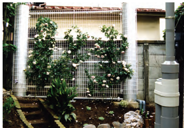
◀ 同じくトーテツの「レインポストⅢ型(容量300ℓ)」との組み合わせ。G.L.から2本のパイプ状タンクの上端までは3m以上あるが、この高さであっても「ぶんりゅうⅡ型」から自然の水圧で送水し、貯水することができる。
