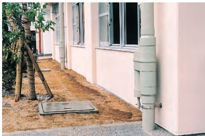
▲ 兵庫県西宮市 津門小学校で。ぶんりゅうⅡ型で浄化した雨水を地下貯水槽(25m)へ導き、散水と草木への水やり利用している。
