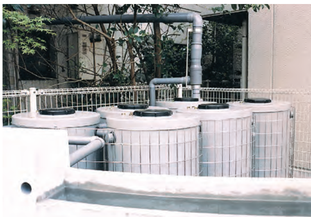
▲ 世田谷区のアメンボ広場で。隣接する民家の協力を得て屋根から雨水を取り、ガーデンオアシスGO-Ⅱ-200、6連式（合計1200ℓ）に貯水し、人工池への補給水として利用している。
