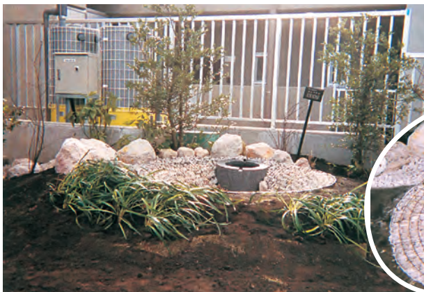
▲ URB都市機構職員宿舎(神奈川県川崎市元住吉)での雨水利用。屋上緑化の一環として、ガーデンオアシスを水源としてパードバス(右側の拡大写真)等に水供給している。
