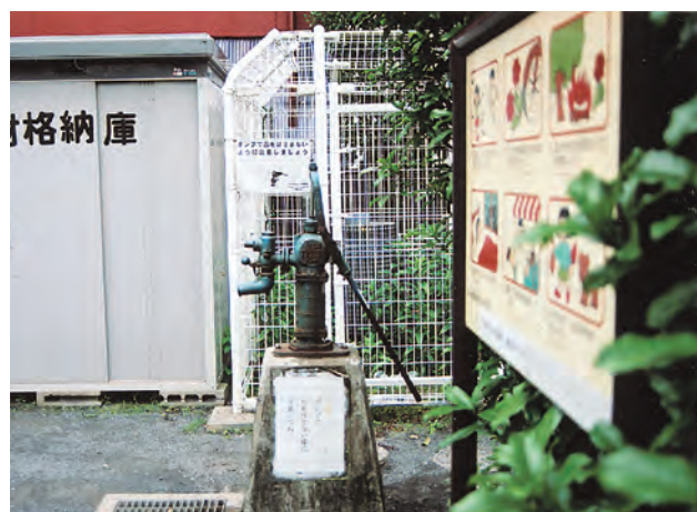
▼ 大田区の下袋児童公園で。金網の囲いの中のガーデンオアシスGO-Ⅰ-200（容量200ℓ）からガチャコンポンプで汲み出し、散水等に利用している。
