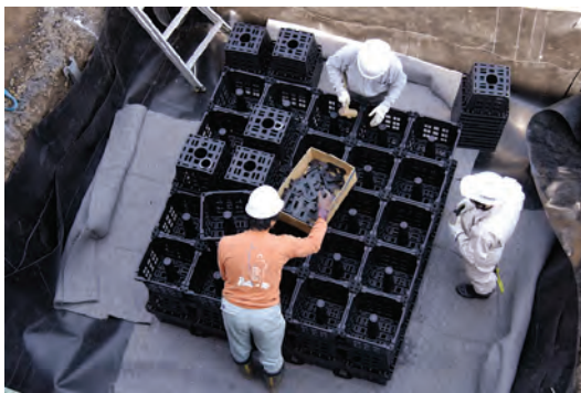
現場での貯留材の組み立て作業
