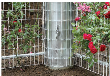
▲ レインポストⅢ型による雨水利用。別に設置された補助タンクからポンプで加圧して送水している。
