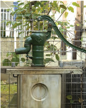
▲地下貯水槽のファミリーダム（容量1m）からガチャコンポンプで汲み上げて散水等に利用している。
