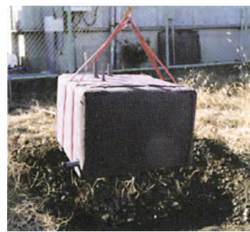
FADの場合、通常クレーンで吊下げて設置する
