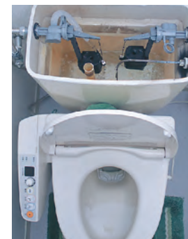
▲ ウォシュレット対応 便器内への流下用の水のみ雨水利用。
