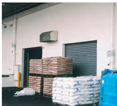
▲ 工場屋根に降る雨は3ヶ所の縦樋に取付けられたぶんりゅうⅡ型で浄化され、地下貯水槽に流下する。
