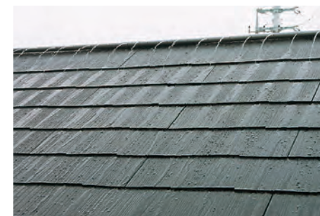
▲ このようなスレートタイプの屋根は屋根散水に適している。屋根から庭に向けて放水して「入工雨」を降らせている例もある。
