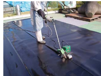
熱融着機による遮水シートの接合作業
