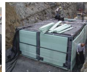
施工中の中規模地下貯水槽
