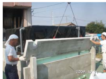
コンクリートフレームの組立作業
