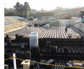
施工中の大規模地下貯水槽
