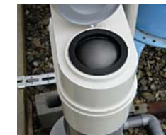
降雨に伴いフロートが浮上して開口部をふさぐ
