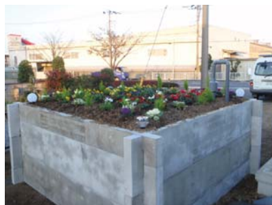
下部を地下に埋設して、上部を花壇にした例
