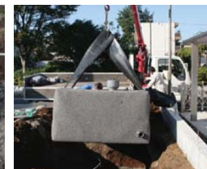
小規模なものは工場で組立てて現場に搬入し、クレーンで吊り下ろす
