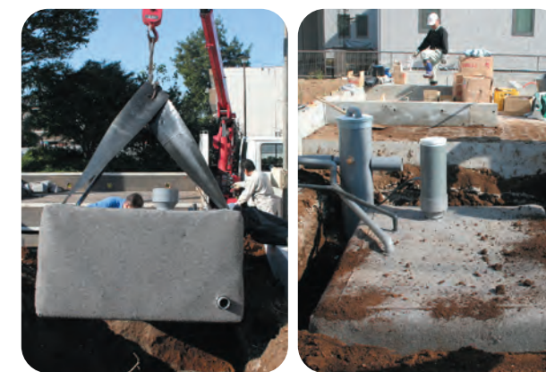
▲ 設置場所：東京都内の一般住宅 利用目的：ビオトープ、トイレ用水、洗車 貯水量：2トン 設置方法：工場で組立てたものを車で搬入し、吊下して設置
