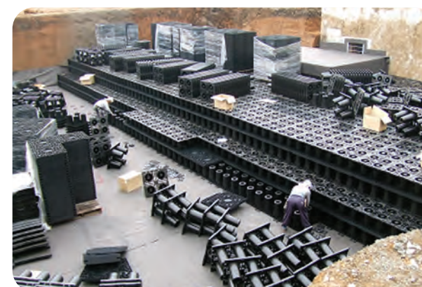
▲ 設置場所：神奈川県内の工場 利用目的：灌水・散水等の利用と流出抑制 貯水量：2,070トン
