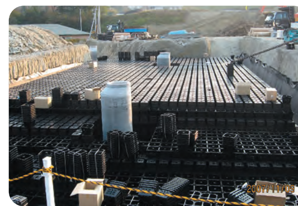
▲ 設置場所：宮城県内のショッピングセンター 利用目的：非常用水、流出抑制 貯水量：1,068トン
