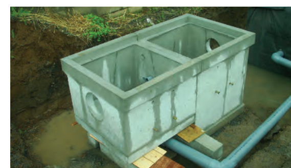
施工中の除塵管理枡
