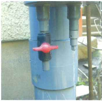
◀写真① オリフィスからは管理ボックス内の雨水を少しずつ排出する仕組みになっている
