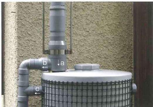
▲ ぶんりゅうⅠ型とガーデンオアシスⅠ型の組合せ 汚れた雨水はbを通して排水。きれいな雨水がaからタンク内へ。cはオーバーフロー。
