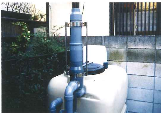
▲ ぶんりゅうⅠ型とレインデポーⅠ型の組合せ 小型で場所をとらない利点がある。
