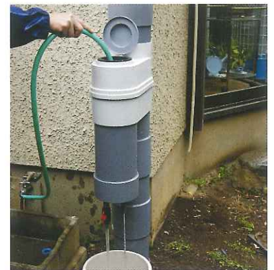
写真⑤ ドレンバルブを開いて塵埃を洗い流す
